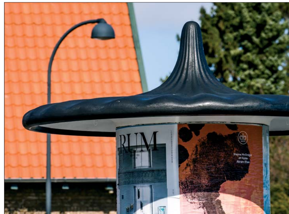
Restaureret plakatsøjle på Ordrup stationsplads (2017). Man bemærker det originale tag med kroge til ophæng af lamper.
